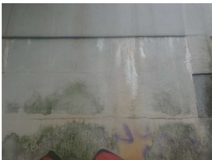
Foto č. 3 Pilíř P 02 – pod úložným prahem v otvoru 2 – průsak vody a pojiva
