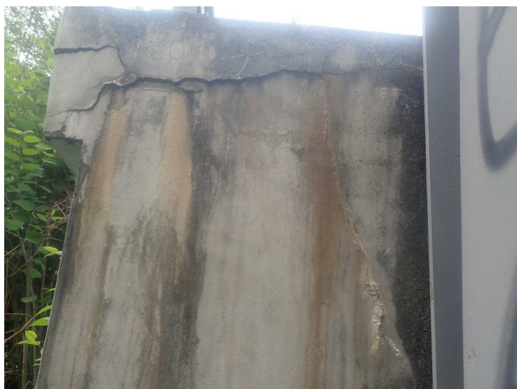
Foto č. 5 Opěra O 02 – závěrná zeď vlevo – trhliny, průsak vody a pojava
