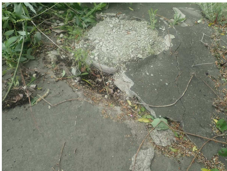
Foto č. 4 Pilíř P 02 – úložný práh na horní ploše vlevo – trhliny a vydrolené zdivo u destrukčního otvoru
