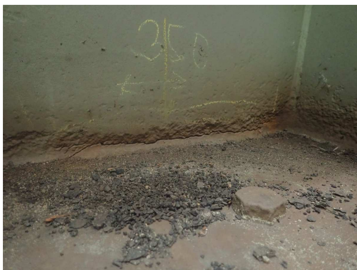
Foto č. 1 konstrukce K 01 – nad O 01 – první příčník vlevo – korozní oslabení a trhlina
