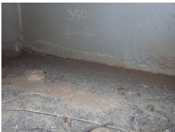
Foto č. 2 konstrukce K 01 – nad O 02 – poslední příčník vlevo – korozní oslabení a trhlina
